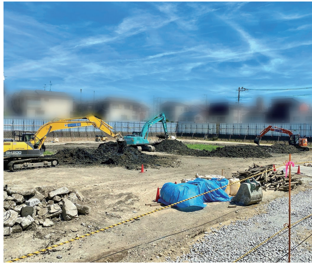
着々と工事も進んでいます！
