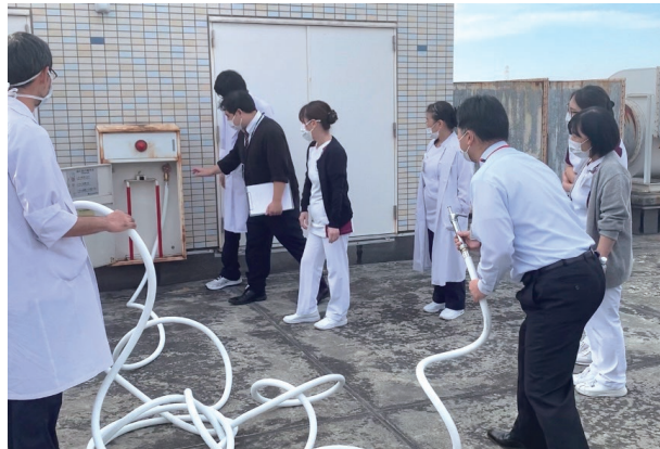
散水栓の確認中
